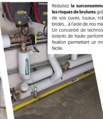
Réduisez **la surconsommation énergétique** et **les risques de brûlures** grâce à l'étanchéification de vos cuves, tuyaux, robinets, vannes, filtres, brides... à l'aide de nos matelas 3D
